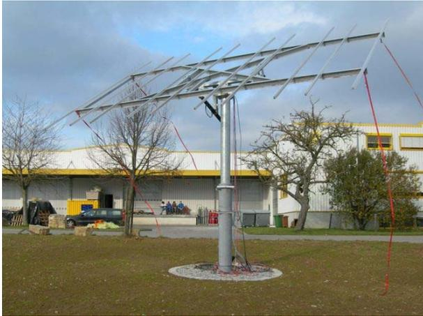
Mast mit Stellvorrichtung und Halterungen zur Befestigung von Modulen
