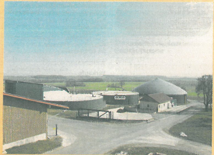
Die Energieerzeugungsanlage verwendet 100 Prozent der erzeugten Energie und ist flexibel beim Substrateinsatz. Foto: Novatech
